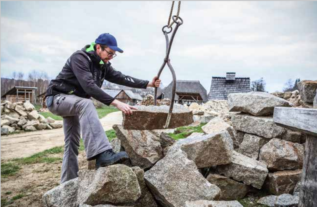
Arbeitstechniken des Mittelalters. Der hölzerne Kran hievt die schweren Granitblöcke zum Mauerwerk. Auf sichere Schuhe aber will keiner verzichten.
